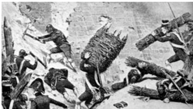
Sapeurs du Génie au travail au cours d'un des très nombreux sièges entrepris par les Français tout au long de la guerre dans la Péninsule.
